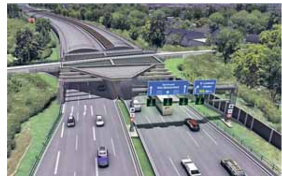
Rasanter Bau: Der künftige Glastunnel.
