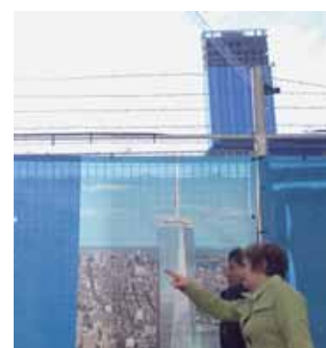
Künftiges Wahrzeichen: Baustelle des One World Trade Centers. Foto: dpa
