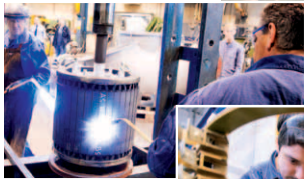
Heiße Jobs: Hier wird gleich eine alte Welle aus einem Antrieb für die Bahn herausgepresst. Dafür muss man das Teil vorher erwärmen.
